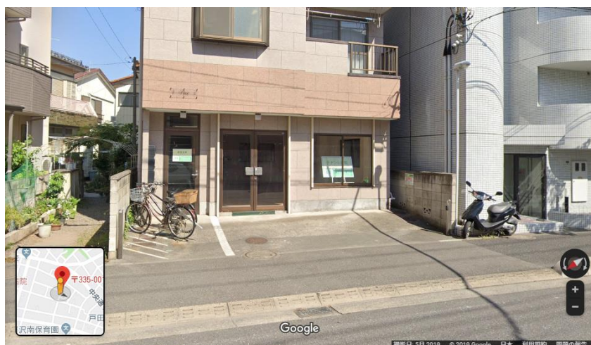
↑ 移転先社屋外観
